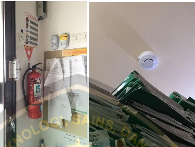
Gambar 4. 4 APAR dan Alat Pendeteksi Asap
